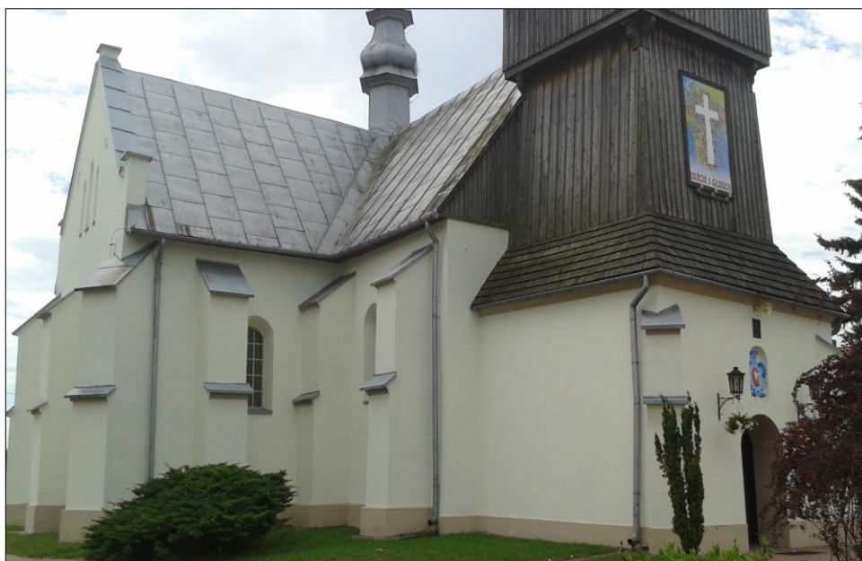
Elewacja od strony półn. - zach.
