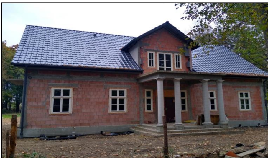
Elewacja frontowa (widok obecny)
