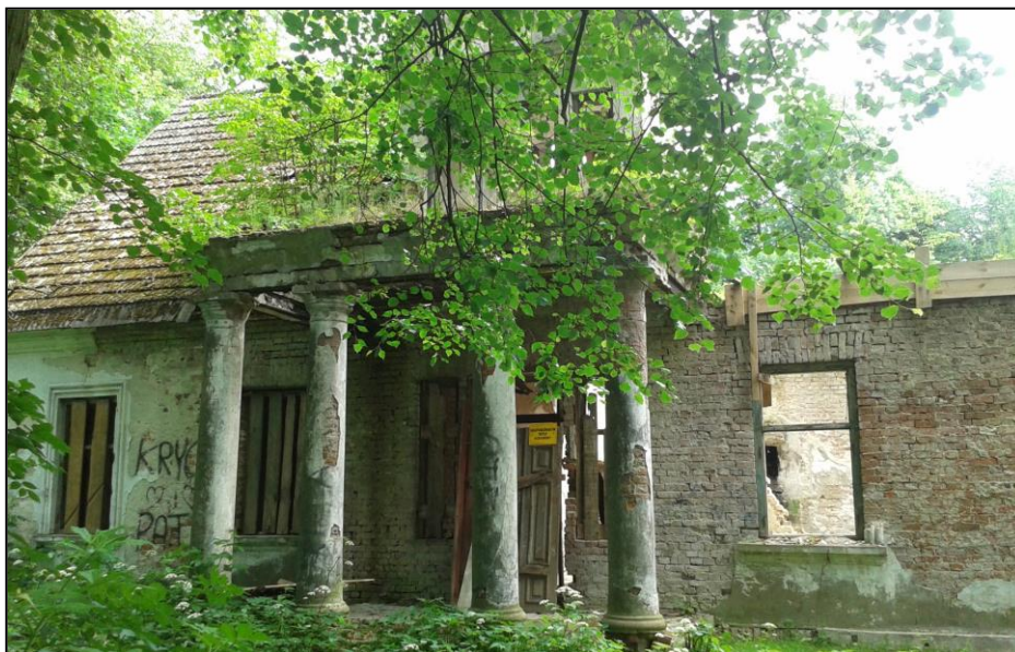
Fragment elewacji frontowej (czerwiec 2017 r.)
