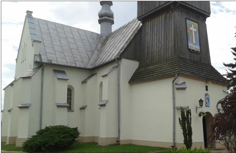
Elewacja od strony półn. - zach.
