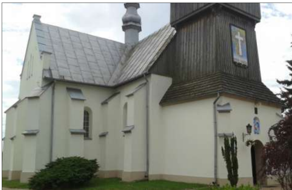
Elewacja od strony półn. - zach.
