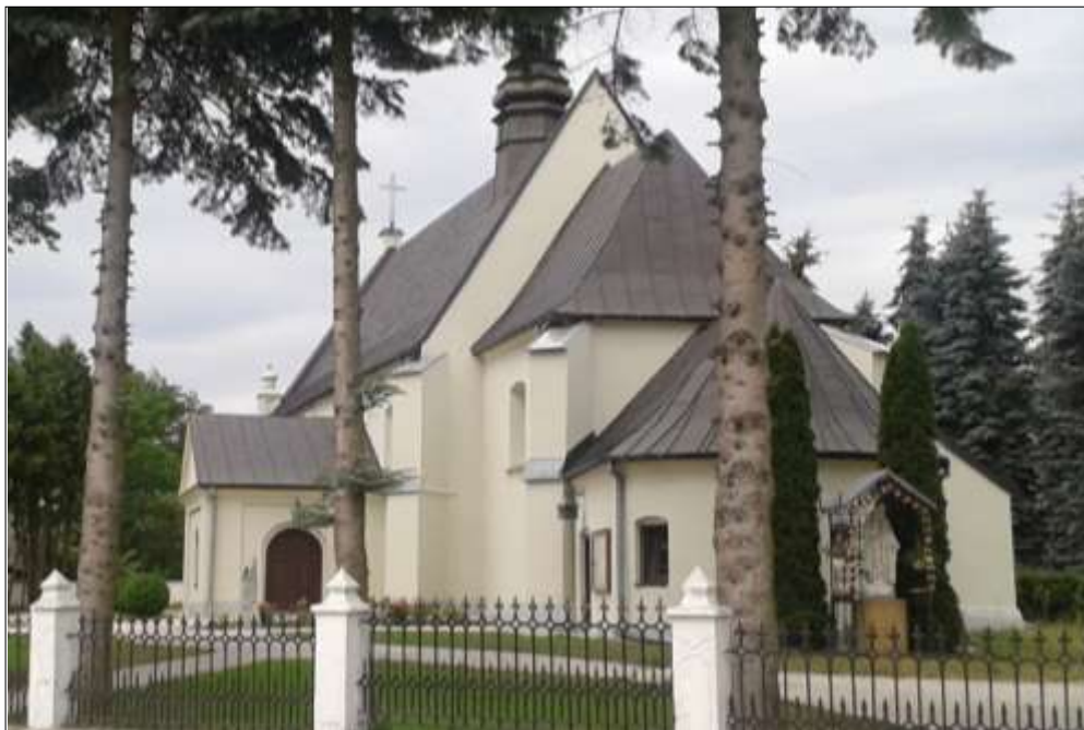
Widok ogólny od strony drogi powiatowe
