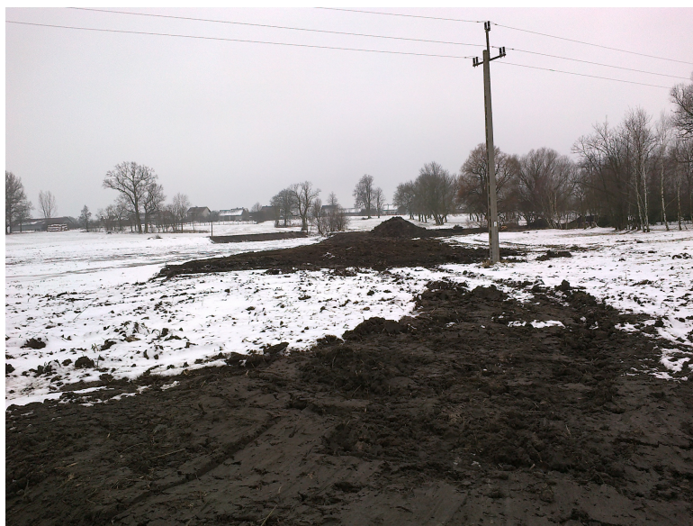
Budowa placu zabaw w miejscowości Zakrzów, gmina Oksa
